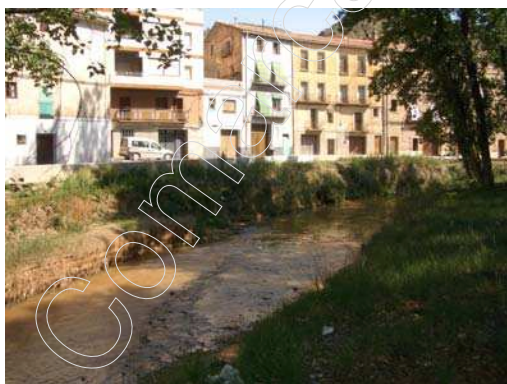
Figura 4: tramo del río Turia a su paso por el núcleo urbano de Libros
